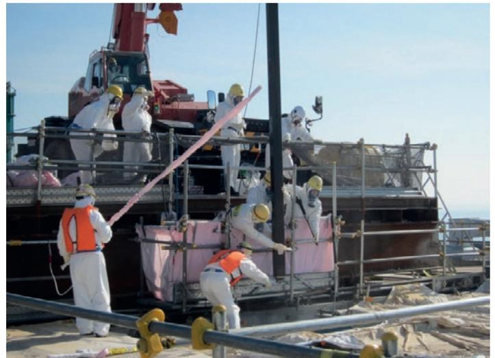
Abb. 6.19: Bergen zweier unbestrahlter Brennelemente aus dem BE-Lagerbecken von Block 4 (Quelle: TEPCO).
