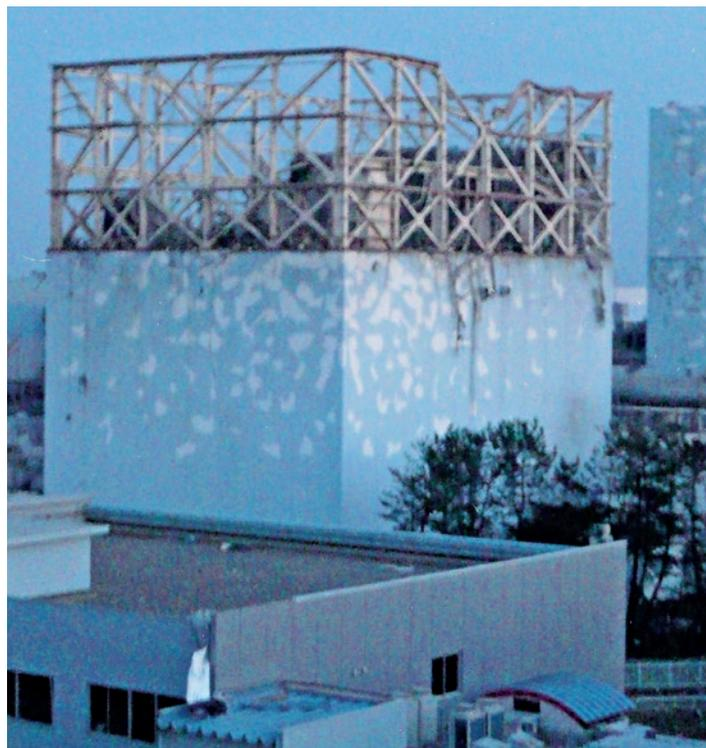
**Abb. 3.14:** Reaktorgebäude des Blocks 1 nach der Explosion am 13. März. 2011 (Quelle: TEPCO).
