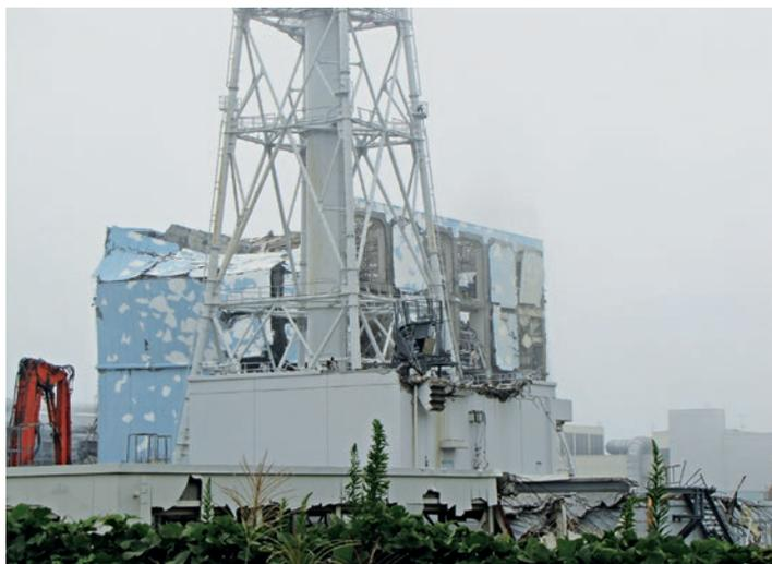
Abb. 3.29: Der durch eine Explosion stark beschädigte Block 4 (Quelle: TEPCO).
