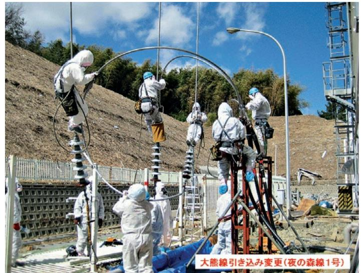
Abb. 6.4: Arbeiten zur Wiederherstellung der Anbindung der Anlage an das Stromnetz (Quelle: TEPCO).
