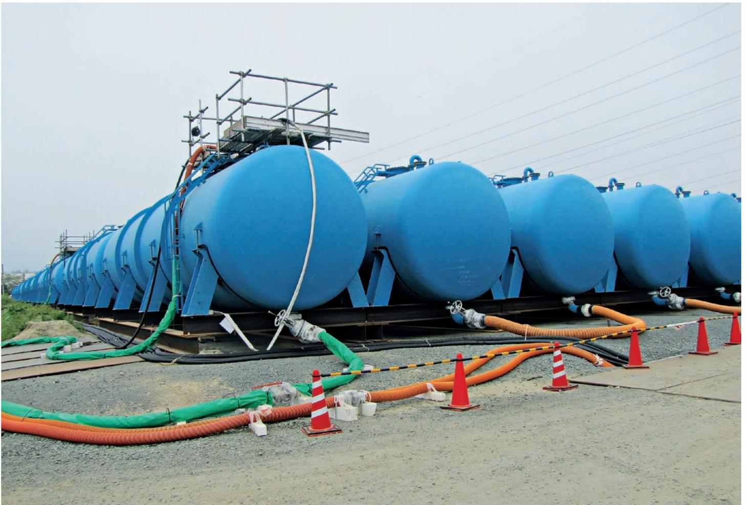
**Abb. 6.6:** Tanks zur Lagerung von kontaminiertem Wasser (100 t) (Quelle: TEPCO).
